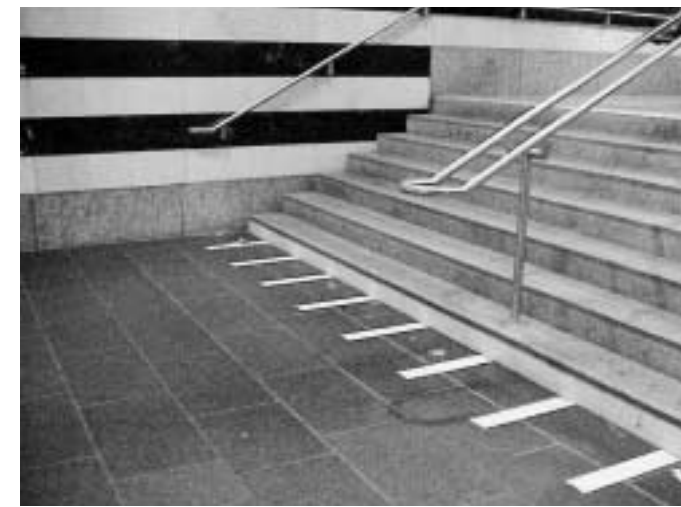
Bild 7: Der Übergang Belag-Treppe wird mit Hilfe von Einlagestreifen auch für Sehbehinderte «sichtbar» gemacht. Feste und sichere Handläufe helfen auch Gehbehinderten die Treppe sicher zu überwinden.
