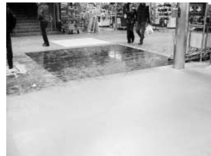
Bild 9: Gleitsicherheitsversuche: Polierte oder fein geschliffene Beläge unmittelbar vor Abgängen können bei Nässe noch ausreichend rutschfest sein. Gefährlich werden die Beläge bei Schneematsch und auf verschmutzten, auch trockenen Oberflächen.
