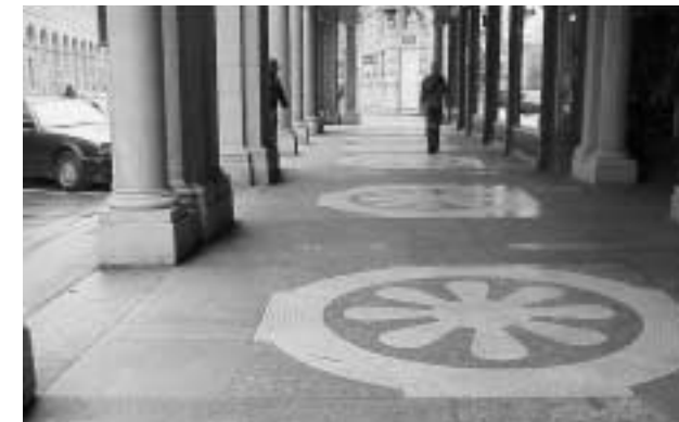
Bild 2: Alte Passage mit Ornamenten aus Feinsteinzeugmosaiken und Natursteinen: Die Gleitsicherheit der grossformatigen Natursteinplatten wird gewährleistet durch die Oberflächenbearbeitung und im Feinsteinzeugornament über die Fugen des kleinformatigen Mosaikes.
