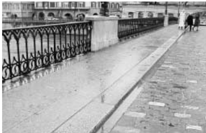
Bild 1: Brücke mit gleitsicheren Natursteinbelägen: Grossformatige Platten auf dem Gehsteig und Pflasterungen im Fahrbereich.
