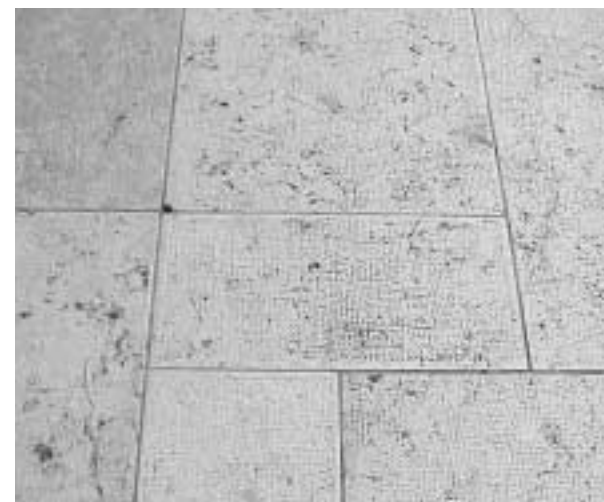
Bild 4: Die Gleitsicherheit wird durch die gekörnte Oberfläche gewährleistet.
