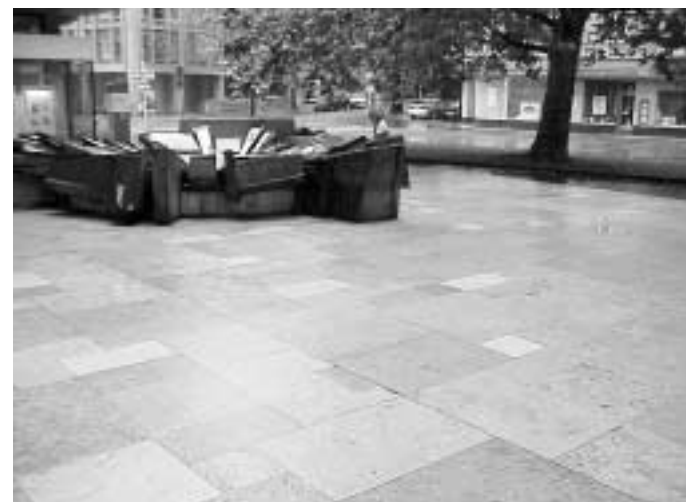
Bild 3: Offener Platz mit gedeckter Passage aus Kalksteinplatten: Die grossformatigen Platten sind in einem sickerfähigen Beton auf einer Abdichtung verlegt.
