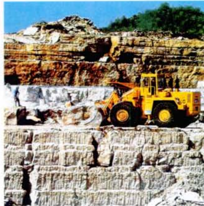
Abb. 10 Jura-Kalksteinbruch mit Loch-an-Loch-Bohrungen
